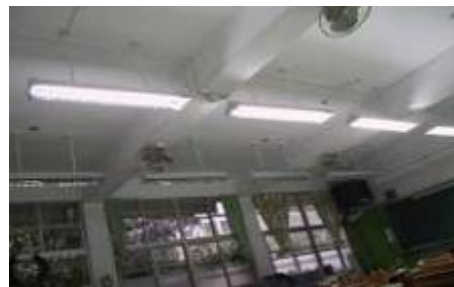
图 8. 配合窗边采光利用将回路与窗户平行设置
